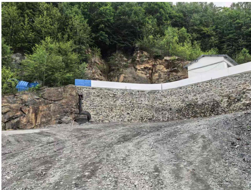
图 3-3 工业广场东北部边坡现状
