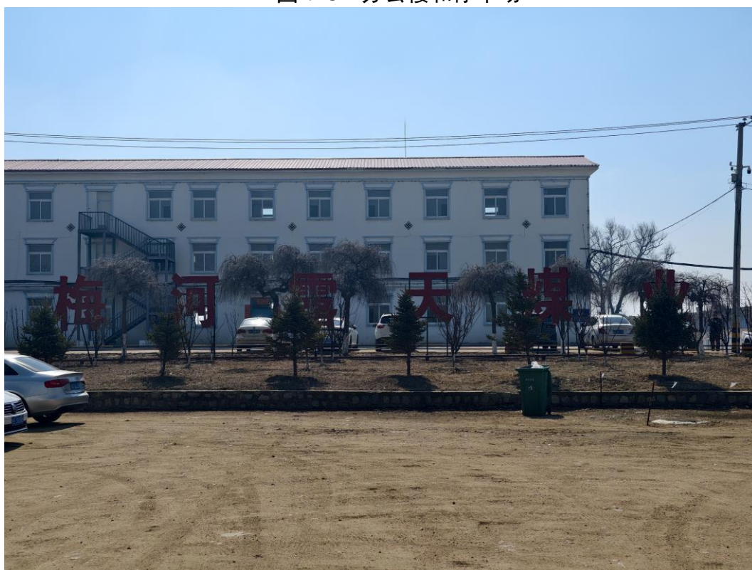
图 1-9 办公楼和停车场
