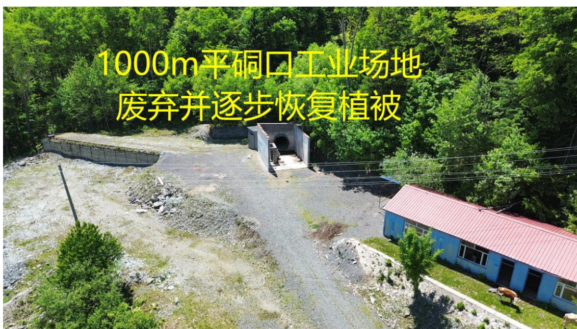
图 3-3 1000m 工业场地局部现状照片
