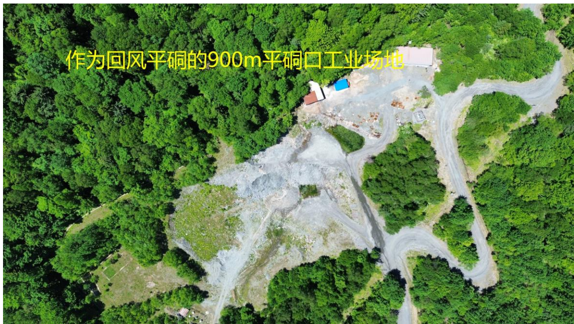
图 3-5 900m（平硐）工业场地局部现状无人机航拍
