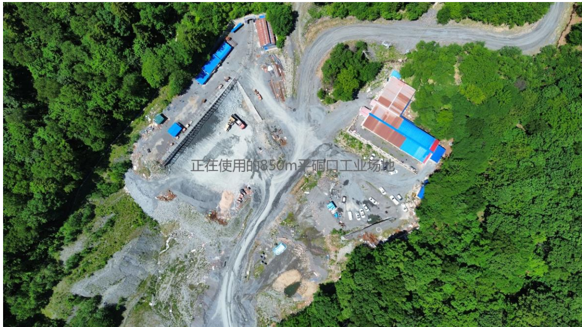
图 3-6 850m（平硐）工业场地局部现状无人机航拍
