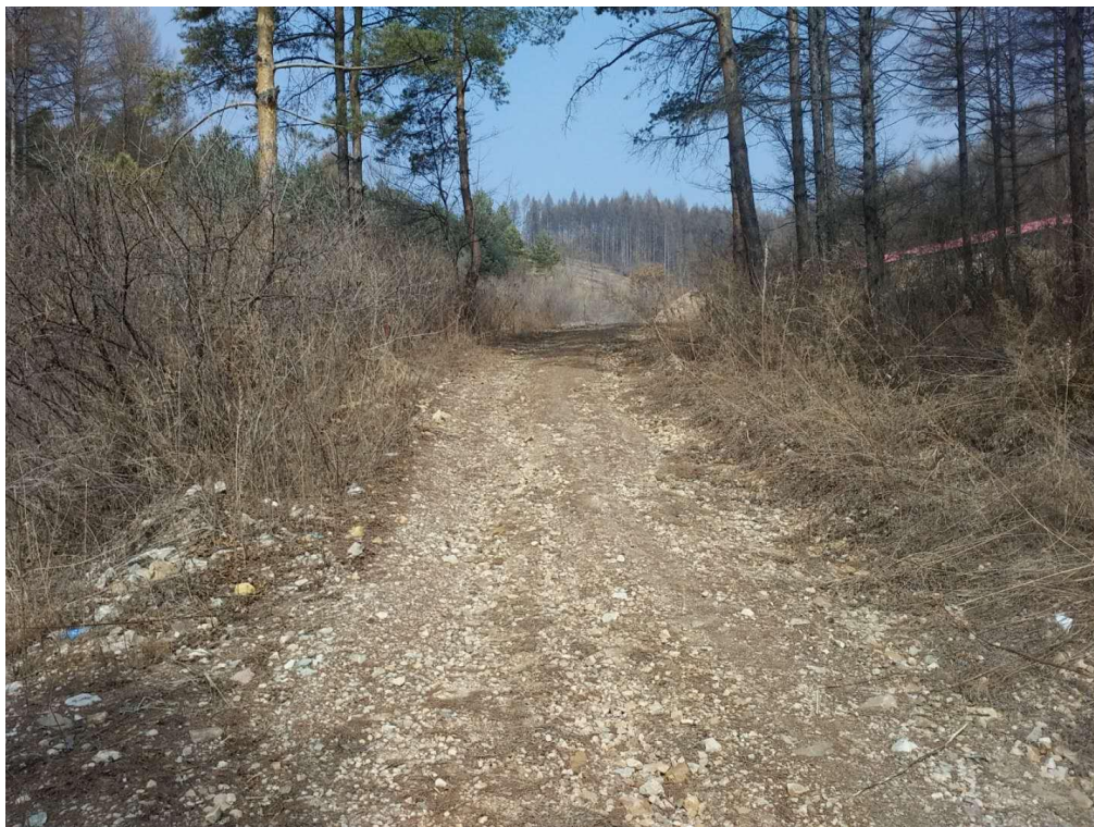
运输道路照片
