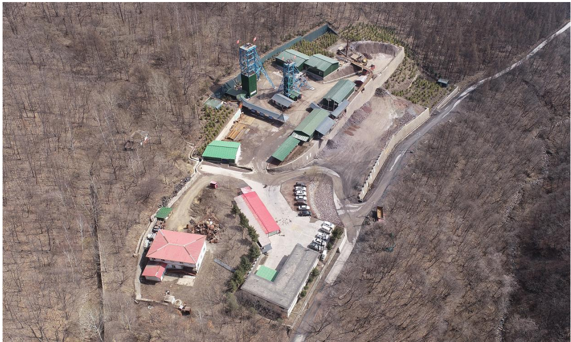
现场照片 1-1 主副井工业广场（拍摄时间 2024 年 4 月 2 日、南东向、大栗子村境内）
