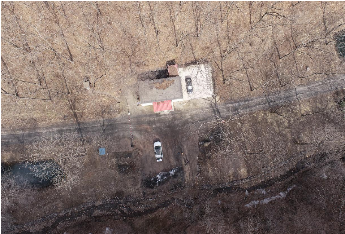
现场照片 1-4 炸药库守卫室（拍摄时间 2024 年 4 月 2 日、北东向、大栗子村境内）
