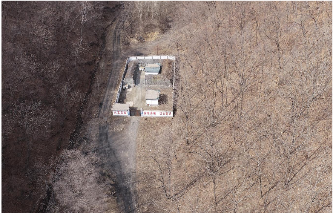
现场照片 1-3 炸药库（拍摄时间 2024 年 4 月 2 日、北西向、大栗子村境内）
