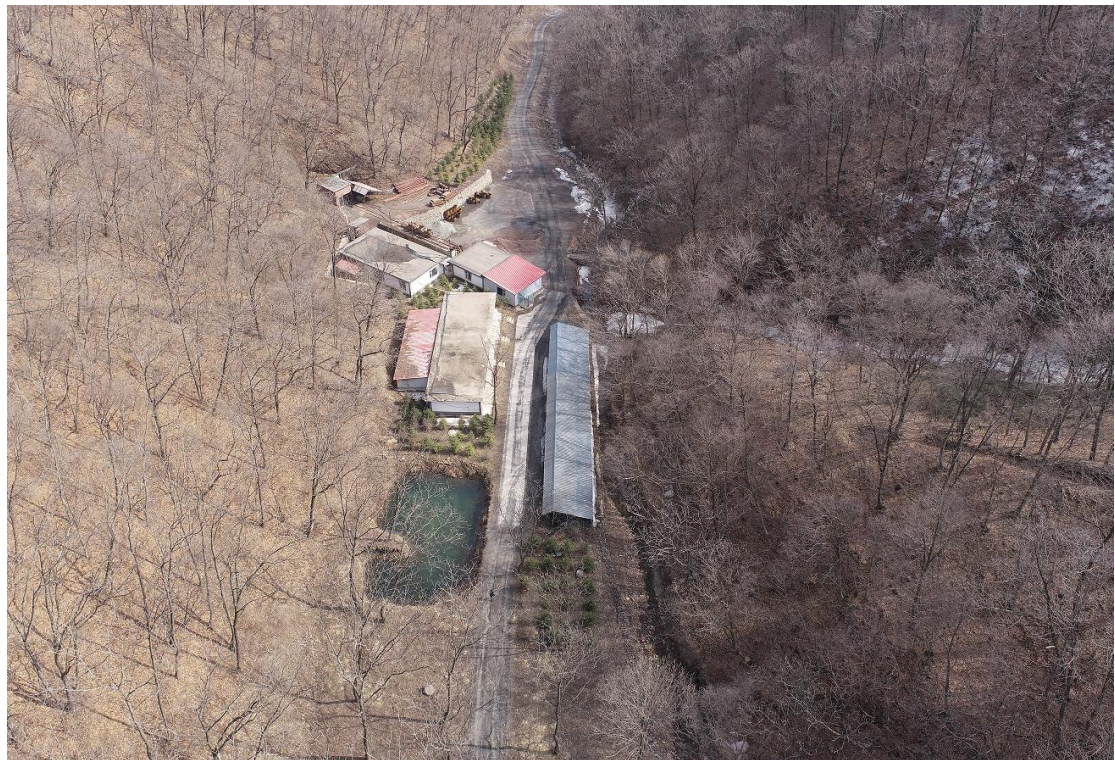
现场照片 1-2 斜井工业广场（拍摄时间 2024 年 4 月 2 日、南东向、大栗子村境内）
