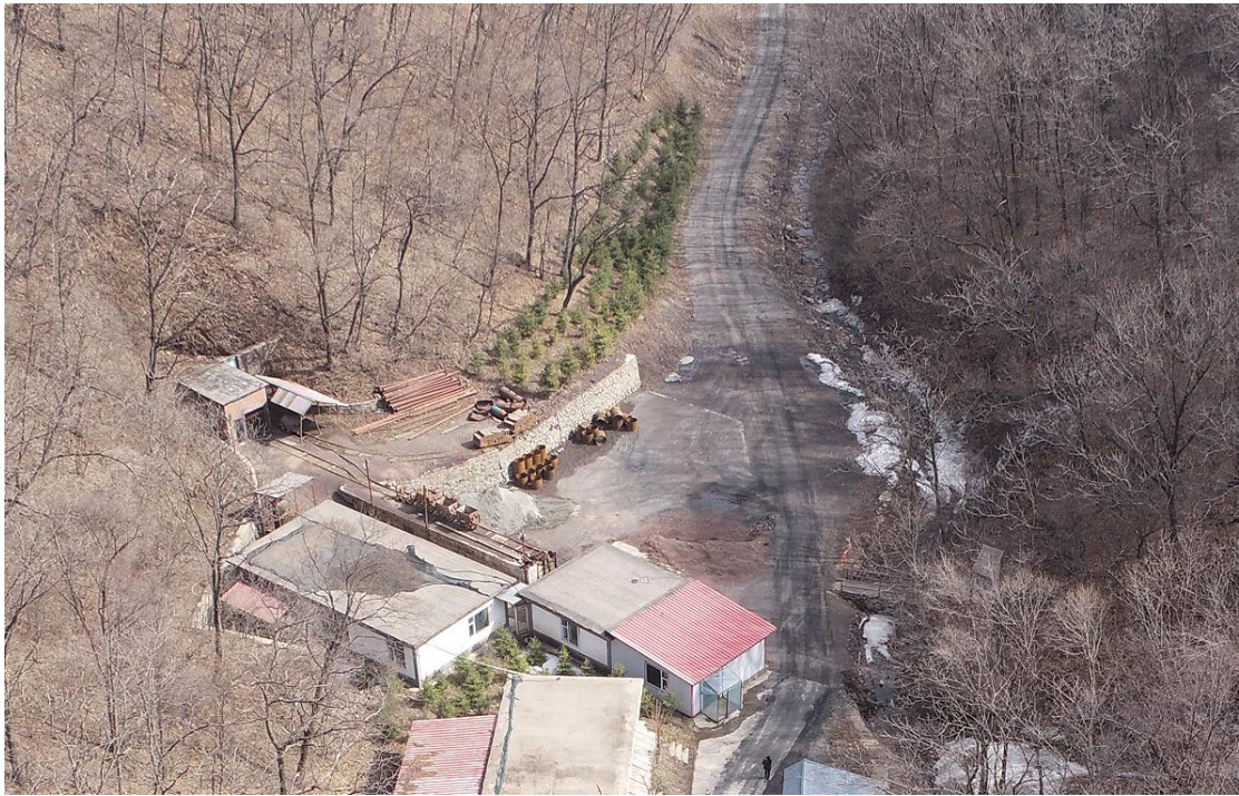
照片 2-7 斜井工业广场治理面积（绿化区域）情况 （拍摄时间 2024 年 4 月 2 日、南东向、大栗子村境内）
