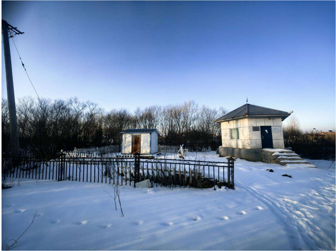
图 1-11 水源地保护建筑及看护房（明川村共用水源）
