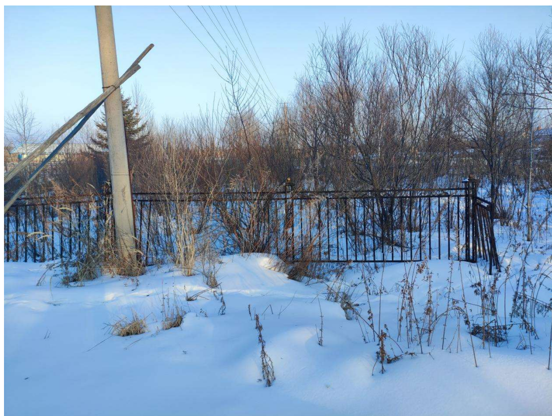
图 1-10 水源地围栏（明川村共用水源）
