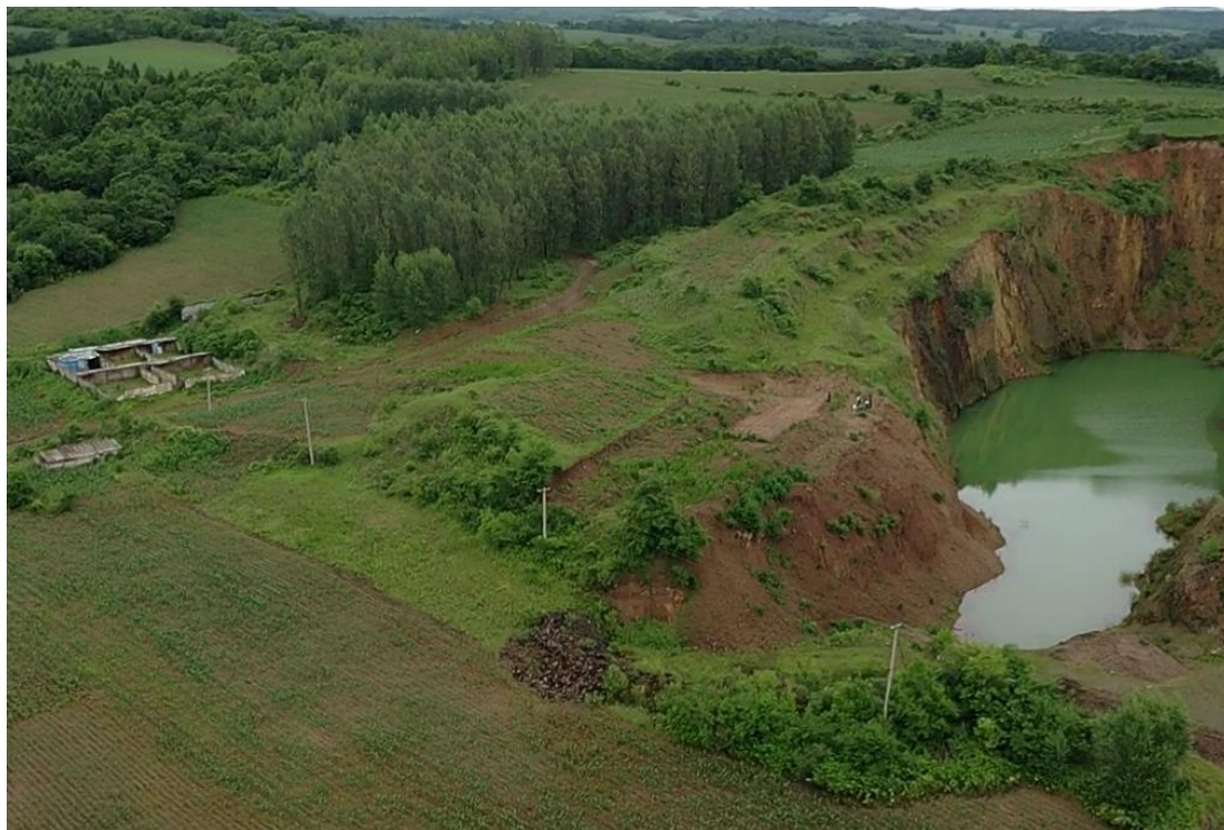
照片 1-2 工业场地现状
